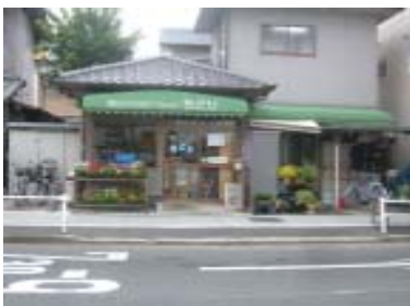
改修工事前。 工事は約2ヶ月かかりました。
